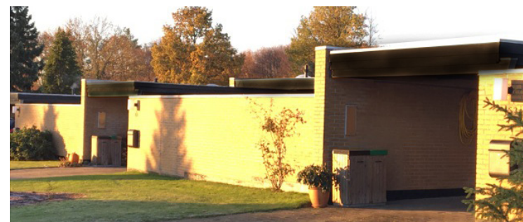
PÆN UDFØRT OMFUGNING MED ZINK AFDÆKNING
