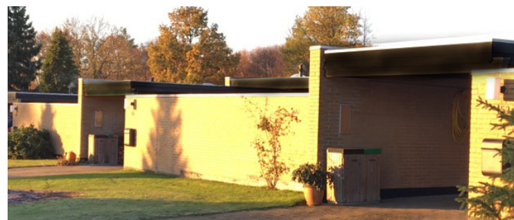
PÆN UDFØRT OMFUGNING MED ZINK AFDÆKNING
