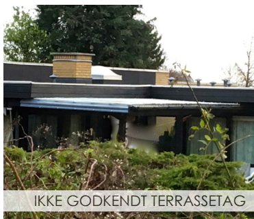
PROFILERET MASSIVT TRÆ ERSTATTET MED KRYDSFINER ER IKKE TILLADT
